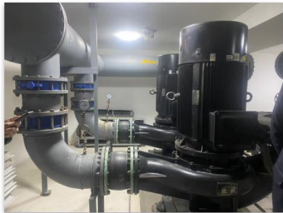
机房内冷却水泵
